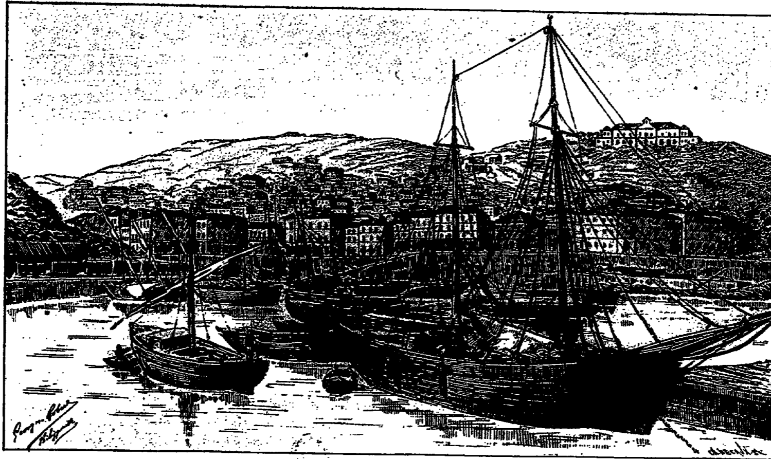
PHILIPPEVILLE (Vue prise du port intérieur)
